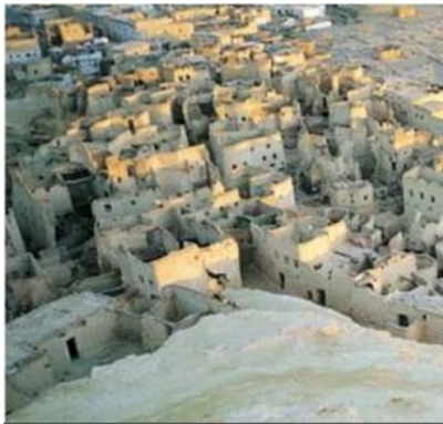
صورة (6) المساكن المُجمعة بسيوة حيث المساكن متجانسة ومترابطة بانتظام، مستطيلة الشكل من دور أرضى واول بُنيت بتقنيات محلية من خامه الكرشيف وجزوع النخل.
