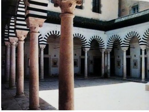
صورة (18) تونس، بلدة Medina of Tunisia المداخل المقنطرة Archway تقوم بدور التظليل وتخفيف من حدة اشعة الشمس والوقاية في الايام الممطرة (عمارة الظل) حول فناء داخلي هو قلب المسكن وجميع العناصر تلتفت حوله وتجذب له ويحوى الانشطة الحيوية ويقوم على الاتصال بين الغرف وافراد العائلة.
